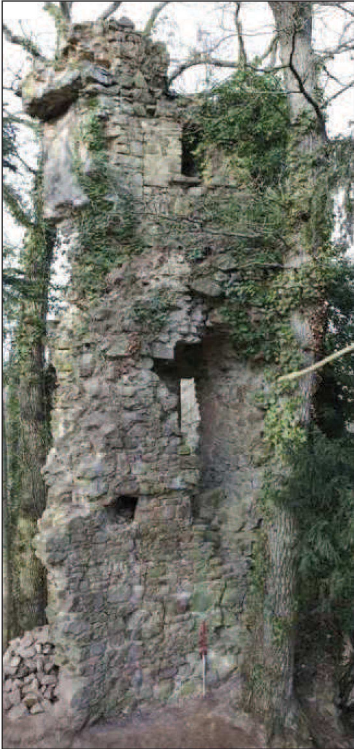
Photo 15 : Parement intérieur de la tour
