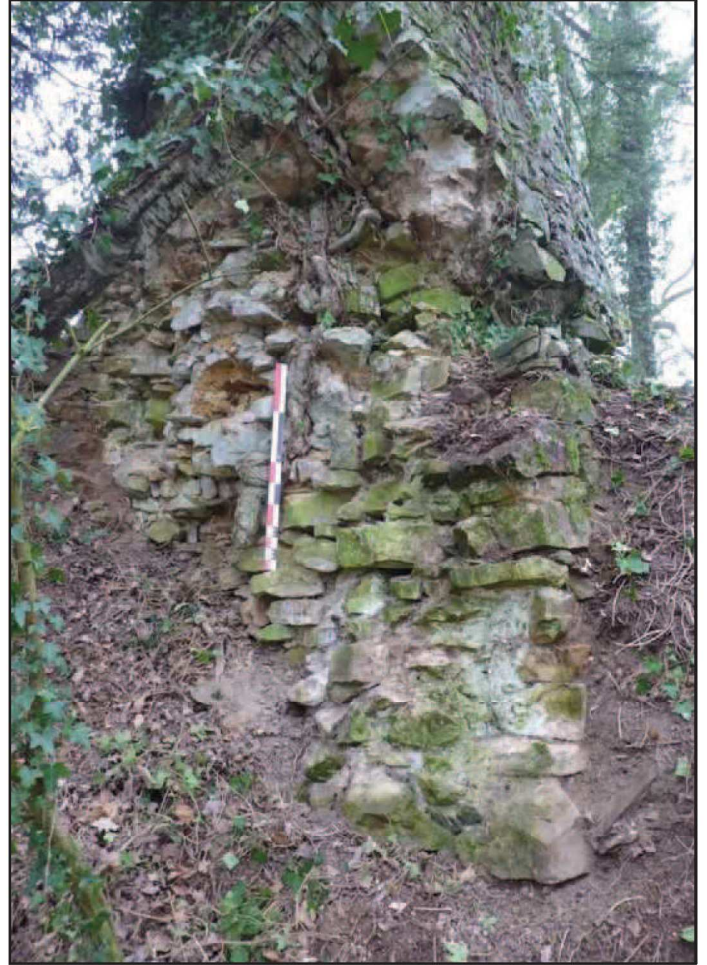
Photo 12 : Fondation et parement extérieur de la tour
