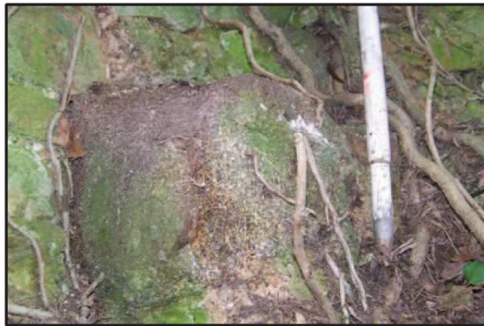
Photo 30 : Élément de marche en granit de l'escalier
