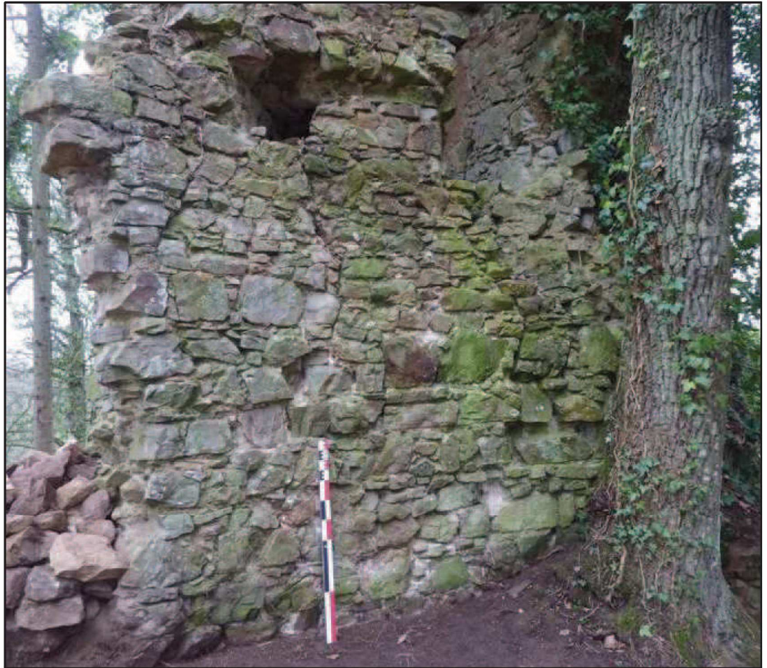
Photo 17 : Parement intérieur niveau 1
