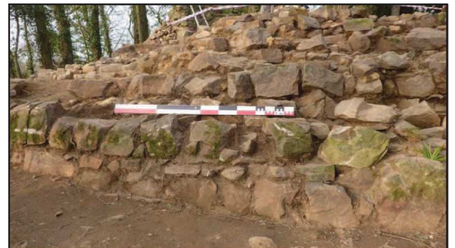
Photo 9 : Parement extérieur dégagé
