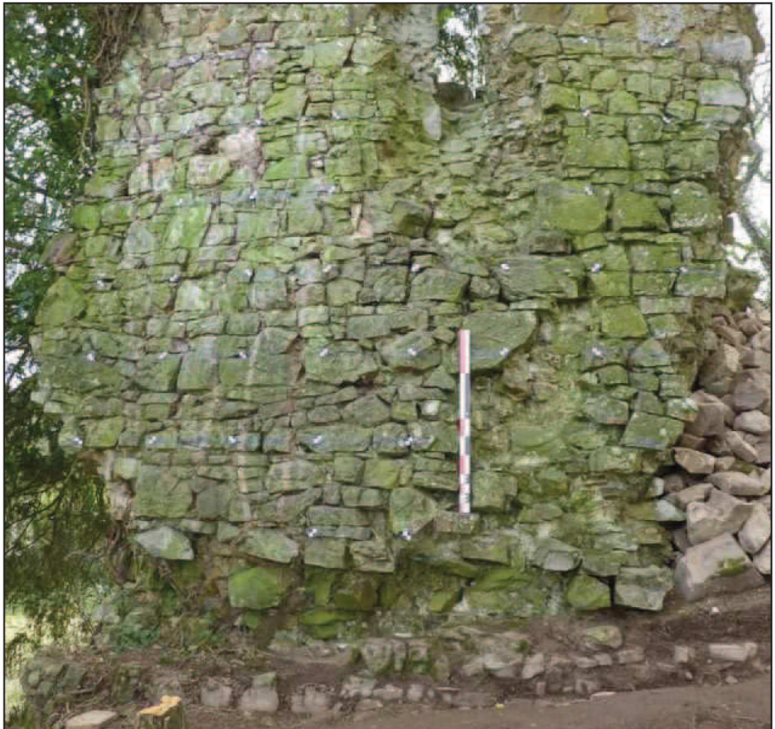
Photo 18 : Parement extérieur niveau 1
