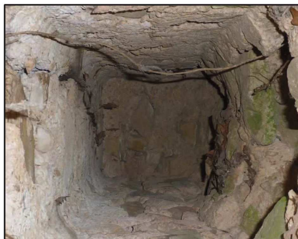
Photo 22 : Négatif de poutre dans la maçonnerie (UC 2)
