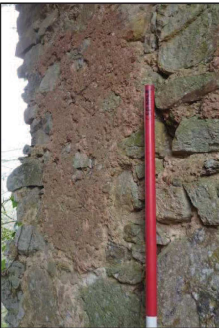
Photo 26 : Détail enduit rubéfié à l'intérieur de l'archère UC 3
