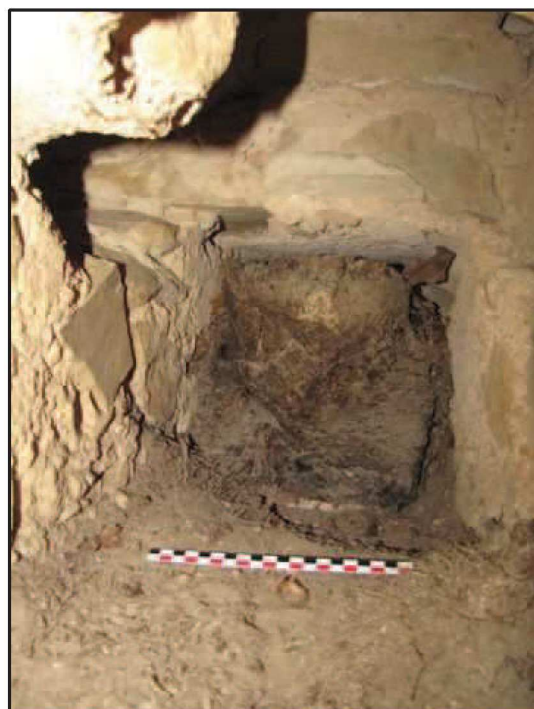
Photo 21 : Poutre bois en place (UC 1)
